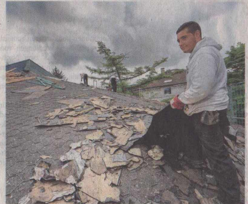
Der Startschuss zur Renovierung der denkmalgeschützten Scharoun-Kirche ist mit der Dachsanierung am Donnerstag gefallen.
